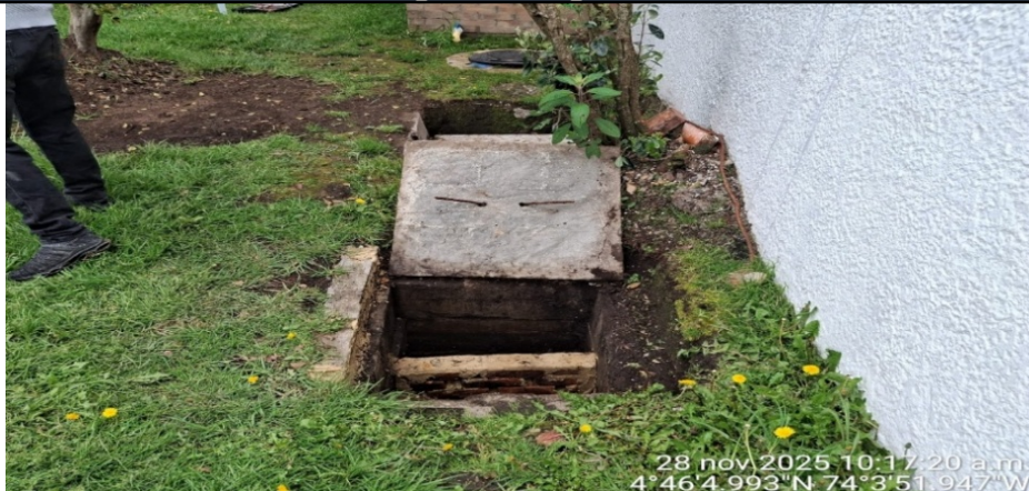
Fotografía No. 6. Presedimentador.
