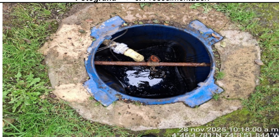
Fotografía No. 7. Tanque de Igualación (sistema general).
