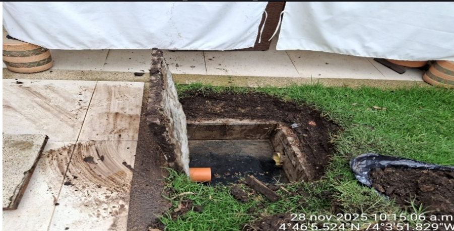
Fotografía No. 3. Caja de Paso de una vivienda.
